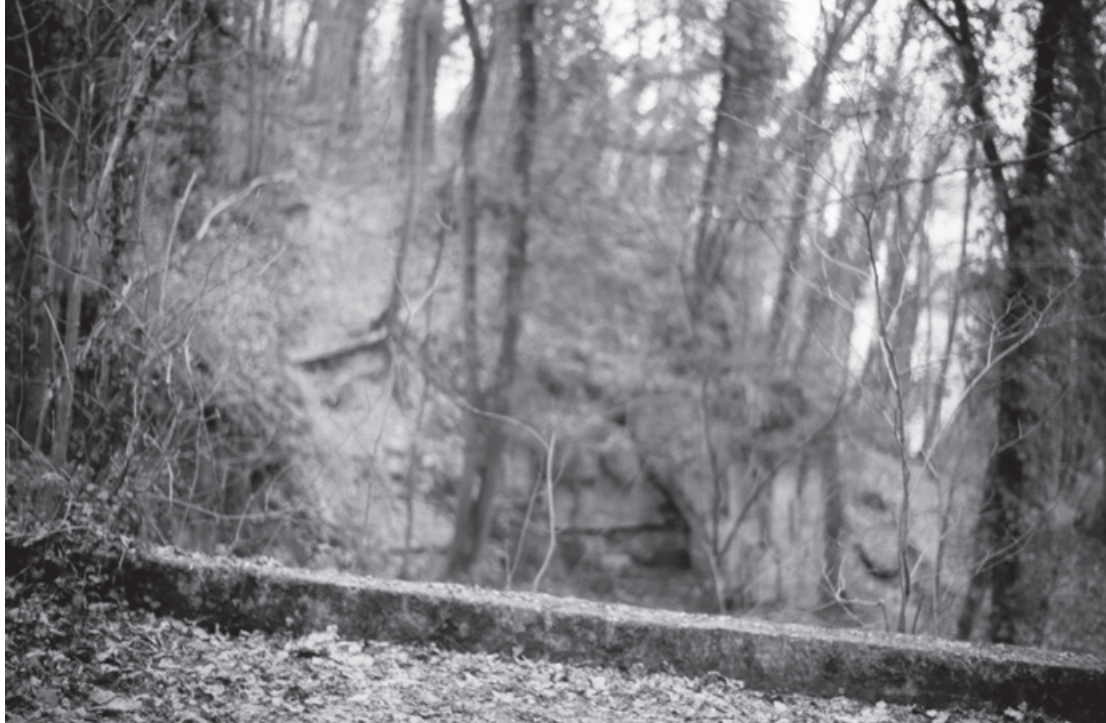
AFBEELDING 2: Betonnen keermuur in haakse bocht (foto: Ton Breuls)
